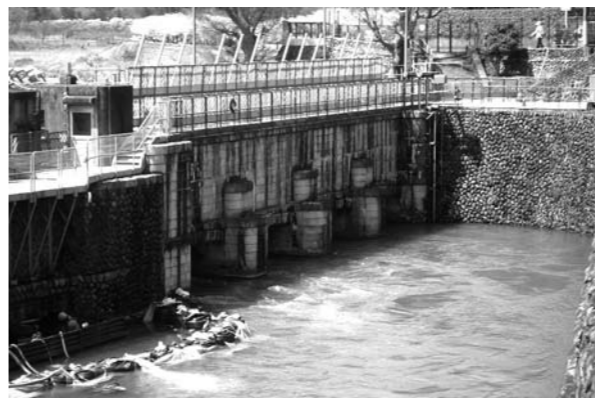
▲玉川上水の取水堰
