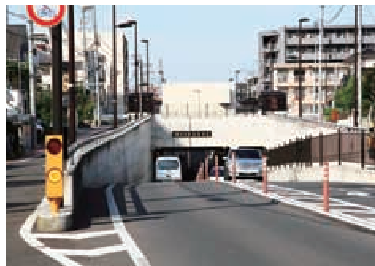
都市計画道路 (3・4・16号線アンダーパス)
