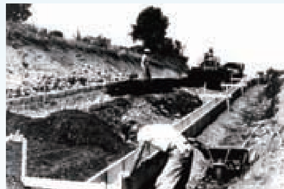
市街地開発工事
