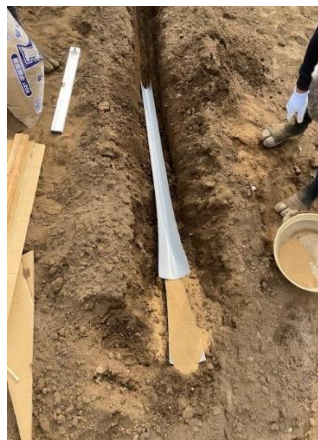
図1 パイプを埋める
