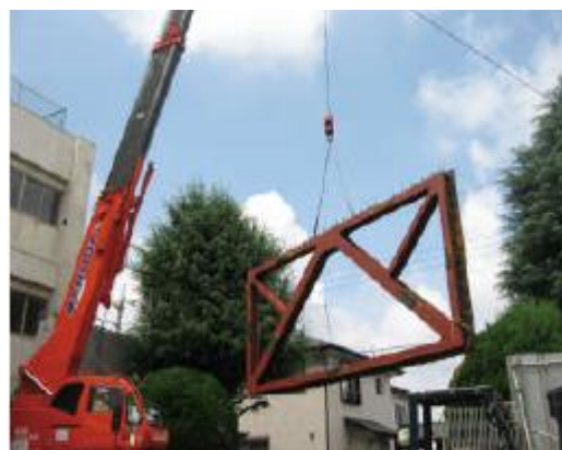
【公共施設耐震改修工事】
