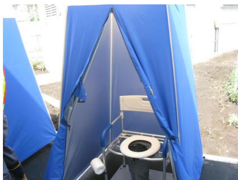
【マンホールトイレ（西小学校）】
