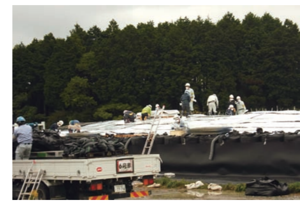
↑汚染土壌や草木の仮置き場(楡葉町)
