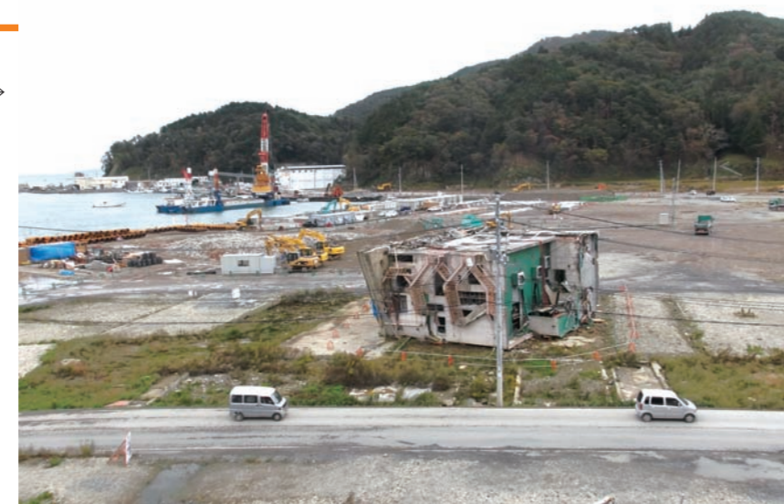
津波で基礎から倒れた建物が残されている(女川町) →
