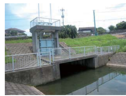
△多摩川土手に設置してある那賀樋管
