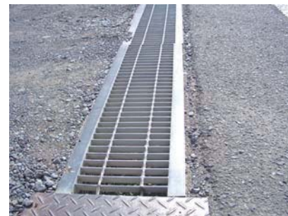
金属をすのこ状にしたグレーチングが使われている道路側溝の蓋
