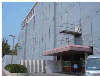
△耐震改修工事中の羽村市役所
