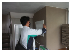
JSによる掲示板の設置
