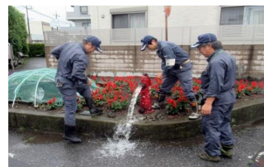
防災部 消火栓点検(毎月)
