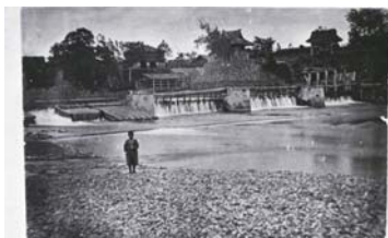
▲明治30年代の取水堰周辺
