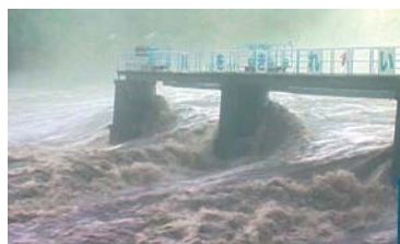
▲台風時の取水堰
