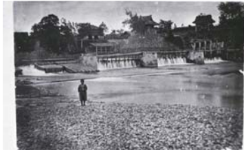
▲明治30年代の取水堰周辺
