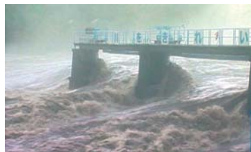
▲台風時の取水堰
