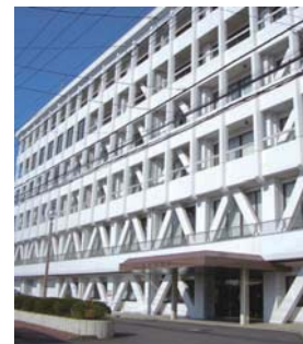
耐震改修工事の終わった庁舎
