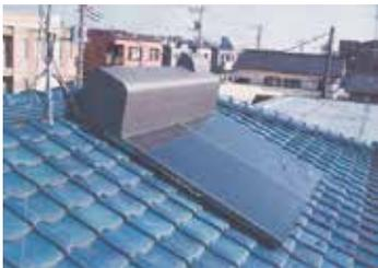
▲自然循環式の多くは、貯湯タンクと集熱器が一体で、太陽の熱を直接水に伝えて温めるんだ。
