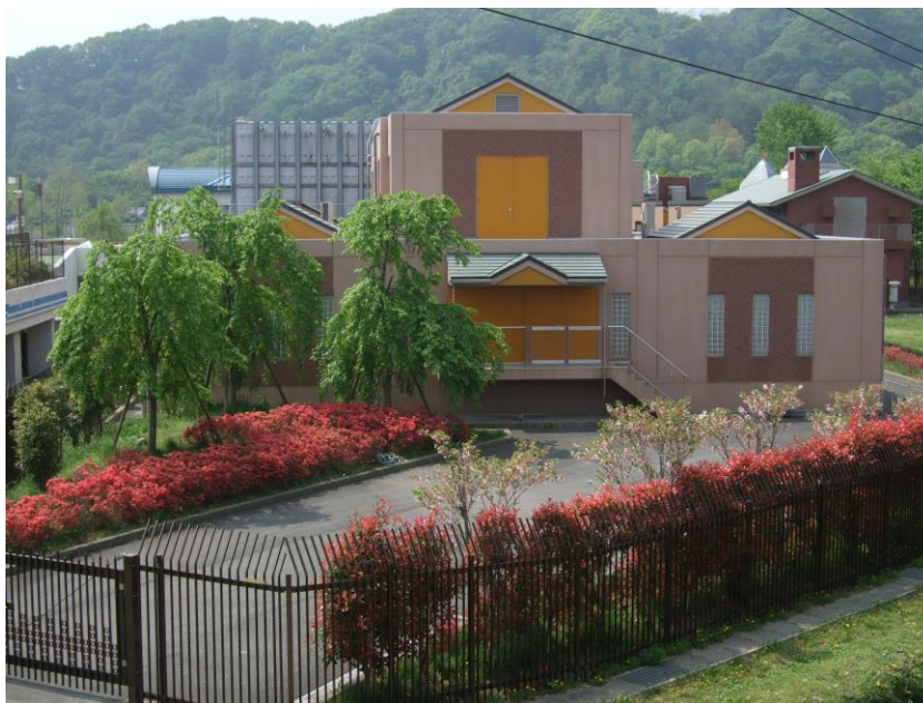
【浄水場・膜ろ過棟】
