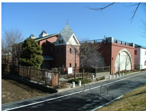
【浄水場・管理塔】
