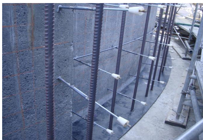
【第 2 配水場高区配水塔耐震補強工事】
