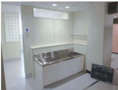
改修された羽村一中トイレの手洗い場
