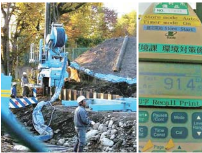
住宅脇での区画整理工事。騒音・振動調査が必要
