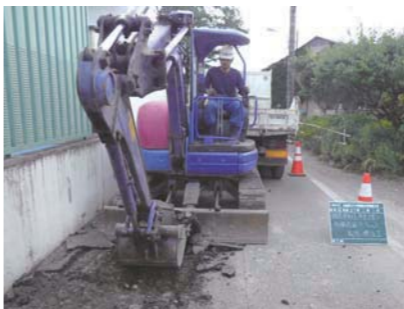
道路の舗装工事の様子
