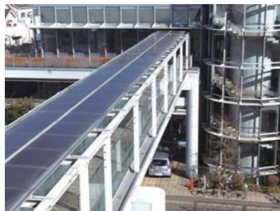
ゆとろぎと図書館をつなぐ交流の橋にも太陽光パネルが設置されている
