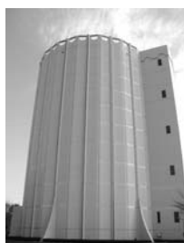
【第1配水場 配水塔】
