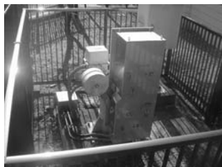
【非常用自家発電機と緊急遮断弁（第 1 配水場）】
