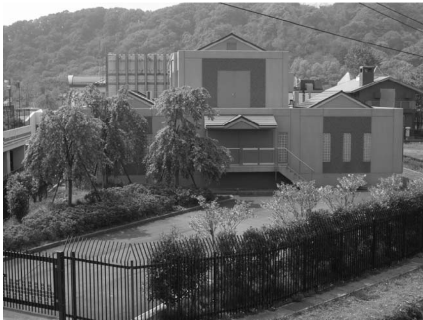
【浄水場・膜ろ過棟】
