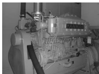
【非常用自家発電機と緊急遮断弁（第 1 配水場）】
