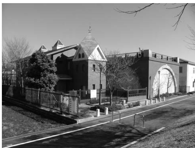
【浄水場・管理棟】
