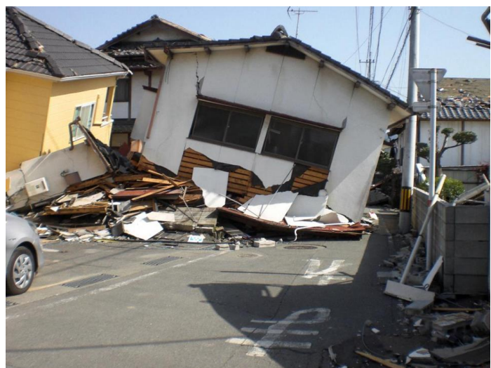
倒壊により道路閉塞した木造住宅
