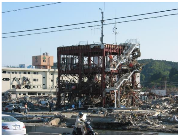
東日本大震災（南三陸町防災対策庁舎）
