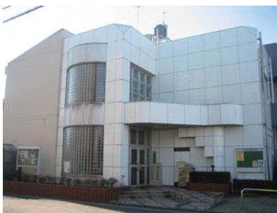
▲小作台西会館
