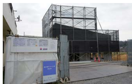
▲建設中のスマイル工房
