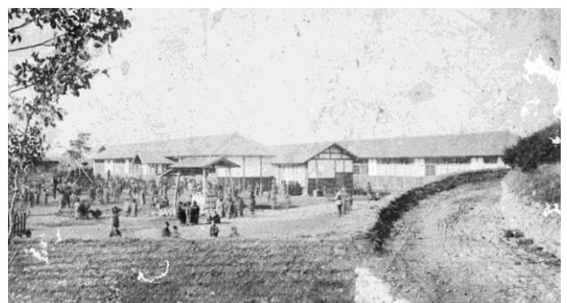
▲竣工間もない頃の天王台校舎
