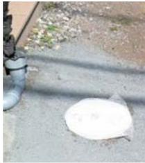
▲地面に埋めて雨水の浸透をスムーズにします
