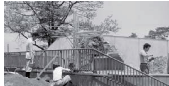
▲建設中の動物公園（昭和 51 年）
