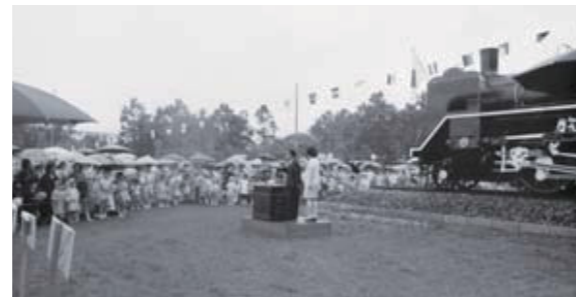
▲蒸気機関車設置記念式典（昭和 50 年）
