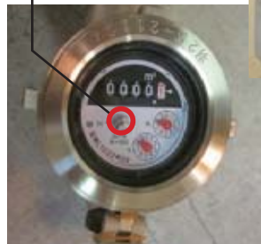
水道を使っていない ときに、メーターの この部分 が回ってい たら要注意！
