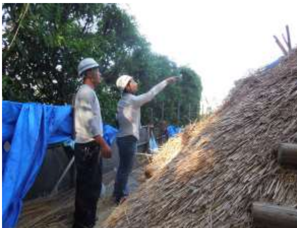
▲旧下田家住宅茅葺屋根の葺き替えの様子
