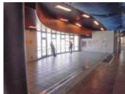
羽村駅自由通路拡幅現況
