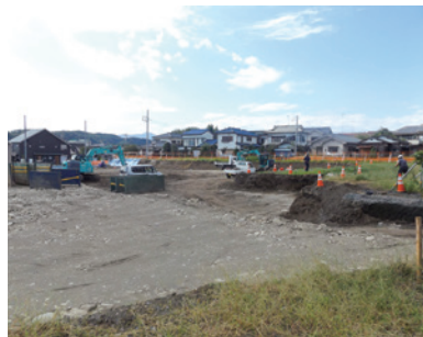
川崎一丁目周辺の区画道路工事
