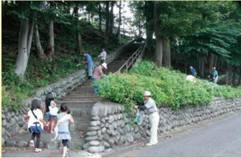
▲羽村駅に向かう生活道路として利用されている
