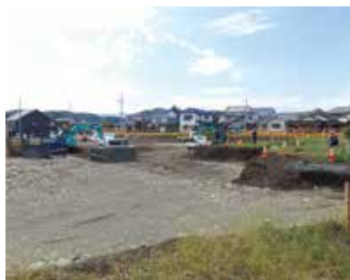
川崎一丁目周辺の区画道路工事
