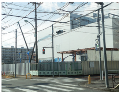
神明台2丁目に建設が進む
