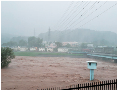
台風発生時の多摩川の様子
