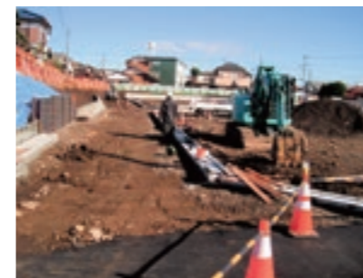
工事が進む川崎一丁目周辺
