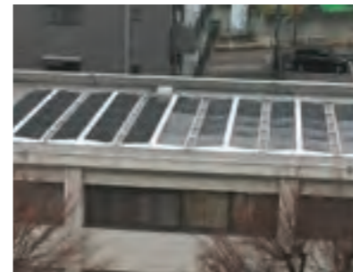
市役所に設置されている太陽光パネル
