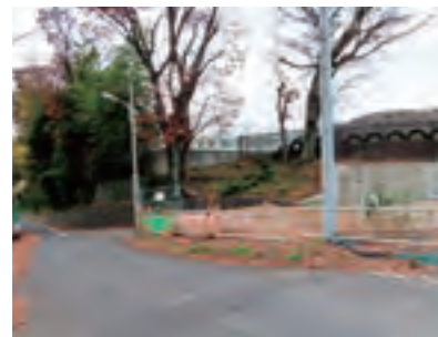
羽村東小学校プール下急傾斜地
