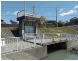
羽中四丁目にある那賀樋管
