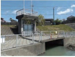
羽中四丁目にある那賀樋管
