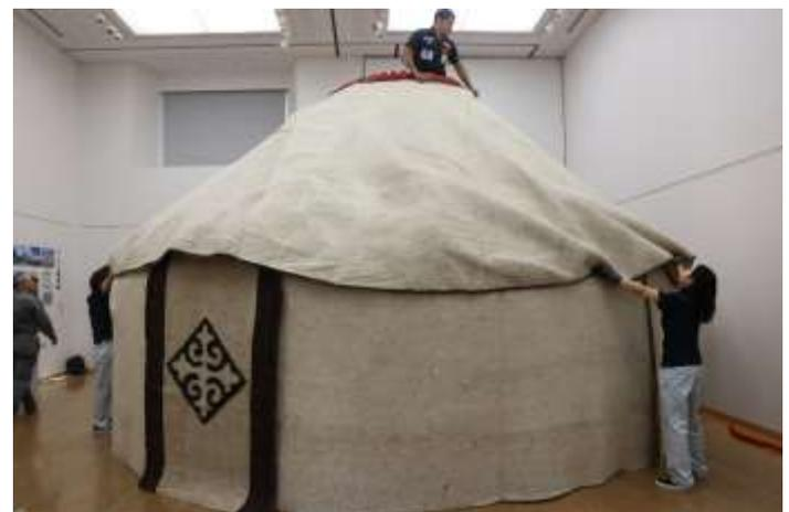
屋根のフェルトは上から引きずり上げ、下から棒で上げる。
