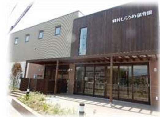
▲建て替えを完了した羽村しらうめ保育園
