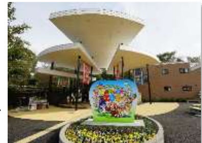
▲改修工事後の羽村市動物公園
