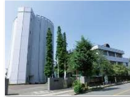
▲羽村市水道事務所
