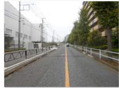
▲神明台二丁目地区へのニプロ(株)の進出に伴い実施した周辺都市環境の整備（歩道整備）
