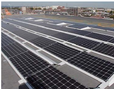
市役所庁舎に設置されている太陽光パネル
