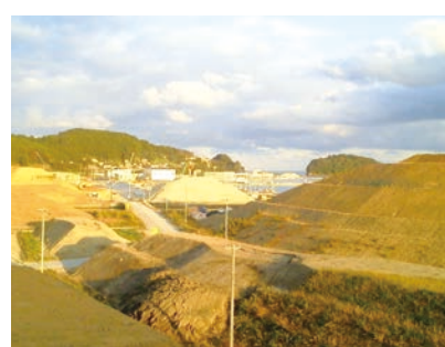
土地のかさ上げ工事が進む南三陸町旧市街地方面（2015年10月撮影）
