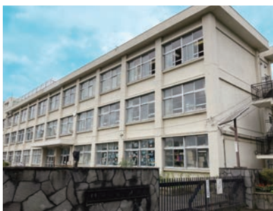
太陽光パネルの設置が進む市内小学校（写真は栄小学校）
