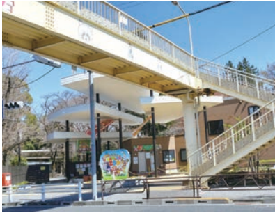
撤去予定の動物公園前の歩道橋
