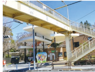
撤去予定の動物公園前の歩道橋
