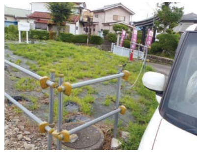
区画整理用地の多くが鉄柵で囲われている
