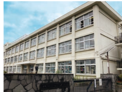
太陽光パネルの設置が進む市内小学校(写真は栄小学校)
