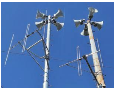
デジタル化整備工事中の防災行政無線 (左：デジタル化後 右：デジタル化前)
