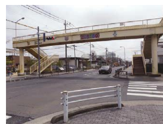
撤去する動物公園前横断歩道橋
