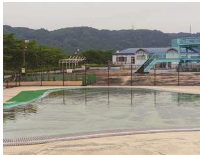
親水公園に隣接する水上公園管理棟
