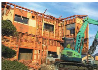
検証が始まった「1000棟の取り壊しや移転を行う区画整理事業」
