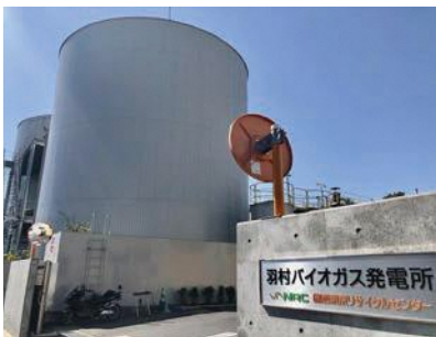
市内にある民間のバイオガス発電所
