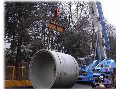
図 下水管（雨水管）の布設工事
