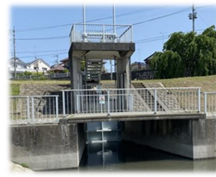
図 那賀排水樋管ゲート(閉まっている状態)
