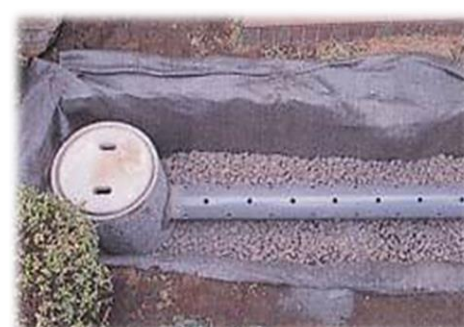
図 雨水浸透施設
