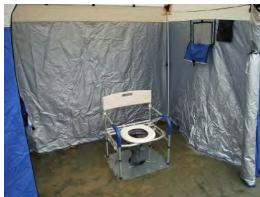
写真 3-14 災害用マンホールトイレ（市内小学校の設置例）
