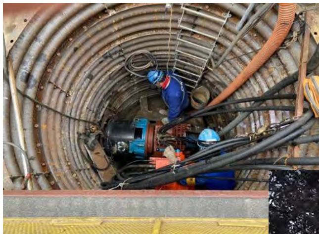
(雨水管推進工法)
