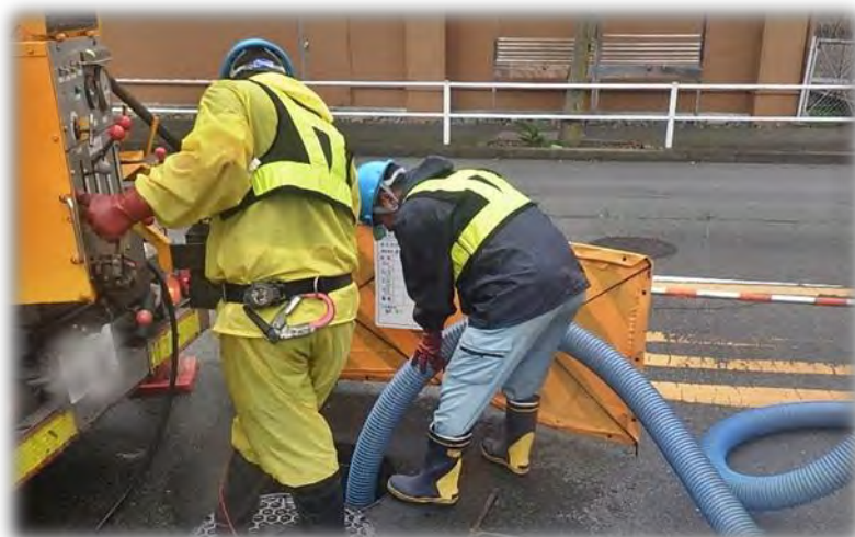
写真 3-10 下水道管路の清掃作業の様子
