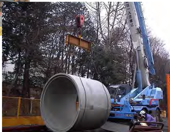
写真 5-3 下水管（雨水管）の布設工事写真
