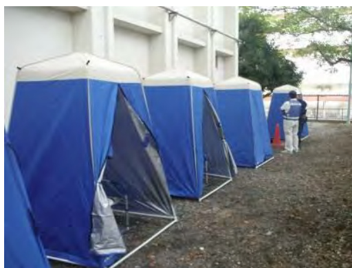
写真 3-14 災害用マンホールトイレ（市内小学校の設置例）
