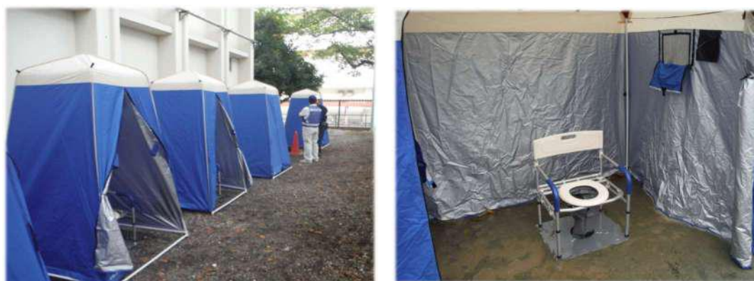
図 3-14 災害用マンホールトイレ(市内小学校の設置例)
