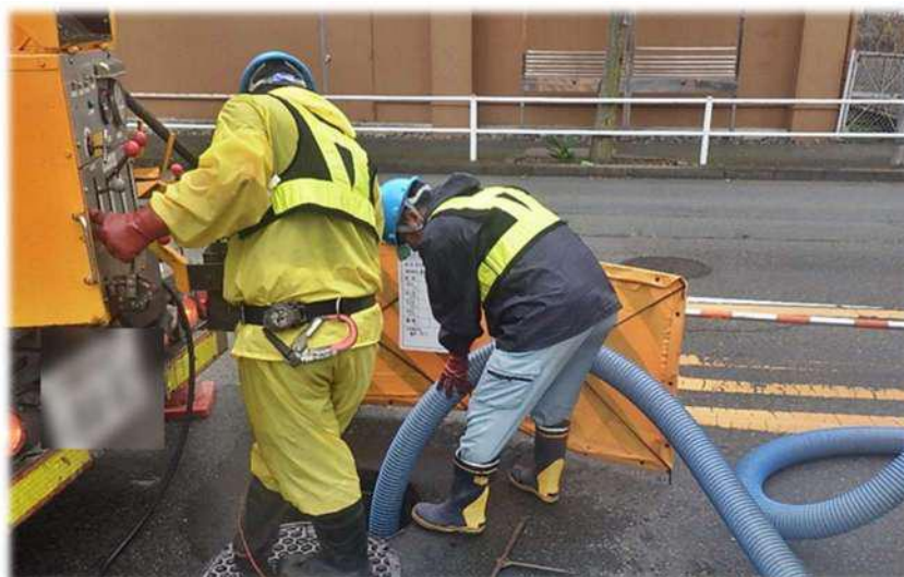
写真 3-10 下水道管路の清掃作業の様子
