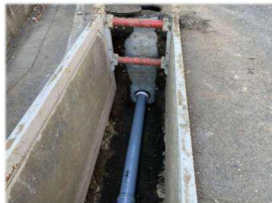
写真 3-4 布設中の下水道管
