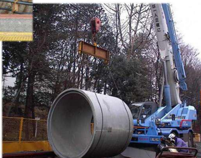
写真 5-3 下水管(雨水管)の布設工事写真
