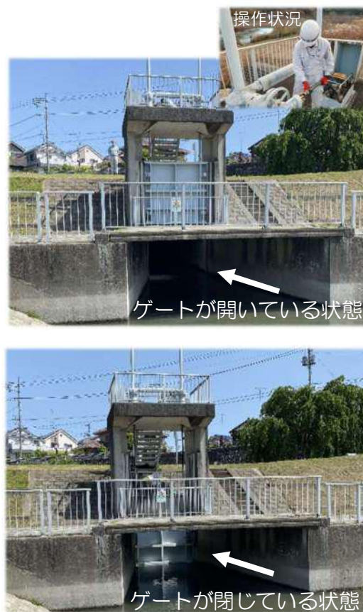
写真 5-8 那賀樋管ゲートの開閉状況(上下)と操作状況(上)
