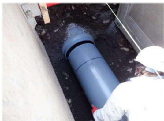
写真 3-4 布設中の下水道管
