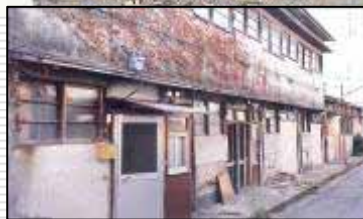
老朽木造アパート
